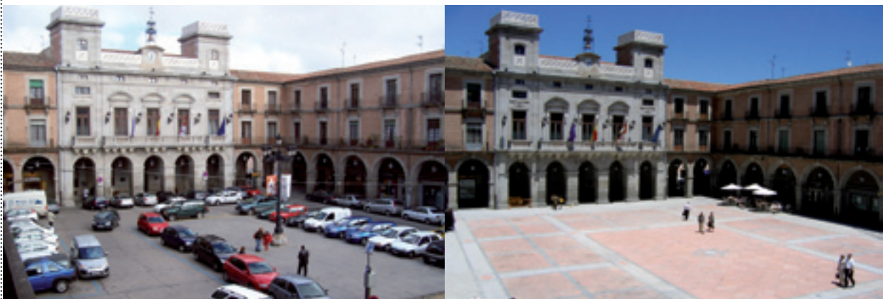
Rehabilitación de la Plaza del Mercado Chico. Ávila
