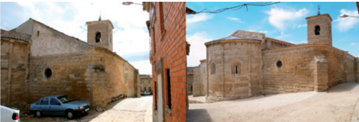
Restauración de la iglesia de San Miguel. Trigueros del Valle (Valladolid)
